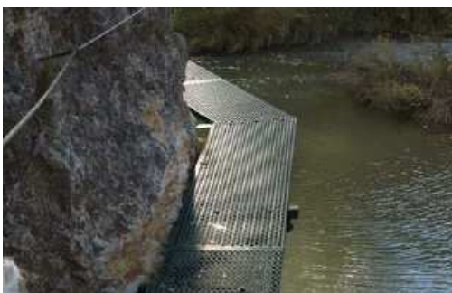
Pasarelas metálicas en el Río Martín
