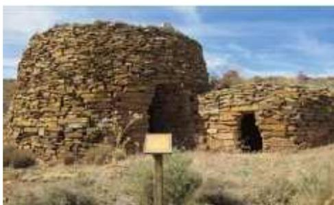
La ruta permite al visitante hacerse una idea de la variedad de construcciones que se pueden encontrar en la zona de Montalbán. Unas creaciones en las que se aplica la técnica de la piedra seca, sin mortero ni ligazón, y cuya estabilidad se consigue mediante el ajuste de peso, presiones y medidas. Unas realizaciones que se integran perfectamente en el paisaje, ya que aprovechan lo que la tierra ofrece.
